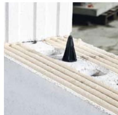
Der Dünnbettmörtel wird mit dem Mörtelschlitten aufgetragen. Die Fugendicke beträgt etwa 2 mm.
