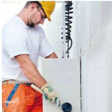
Maueranschlüsse werden in der Regel stumpf gestossen und vermörtelt. In jede Lagerfuge werden Stumpfstossanker eingelegt.
